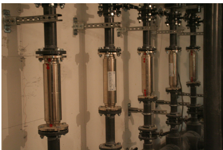
Installation de la batterie d'ISB® sur l'EFG
